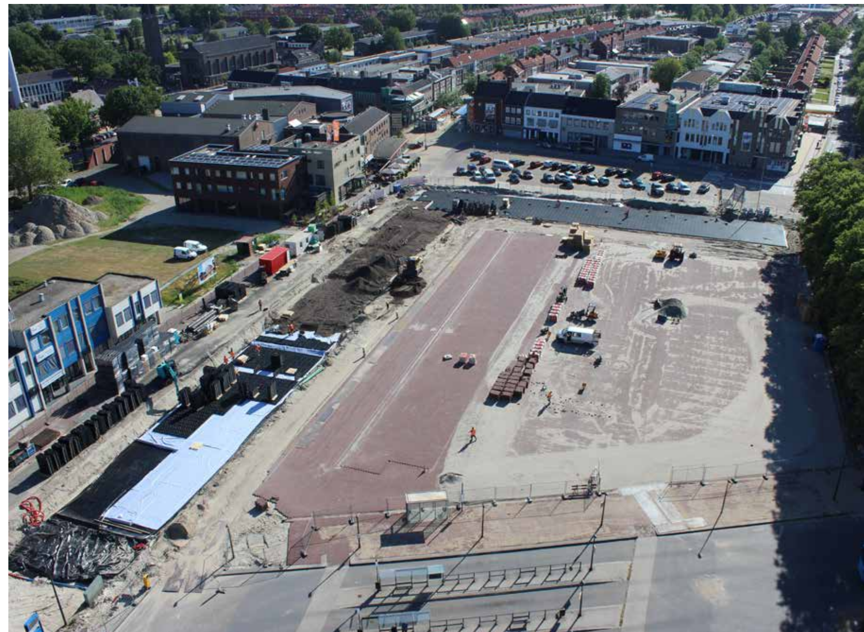
De opbouw van een groeiplaats van 2.600 m 2 in Emmeloord, met 2.000 m 3 bewortelbaar volume en een berging van 1 miljoen liter water.
